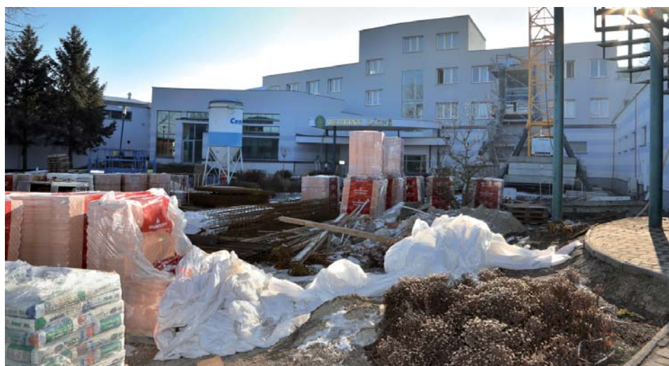
Z kruhového záhonu před jižním vchodem je překladiště obrovského množství stavebního materiálu.
