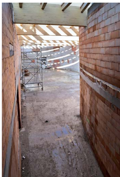
Pohled do bývalého dvora, do budoucí prostorné jídelny.
