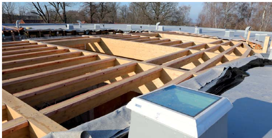
Rozdělaný strop a střecha nové jídelny pro klienty lázní nad dnes již bývalým dvorem. Vedle krovu jsou světlíky, kterými bude proudit venkovní světlo do chodeb lázeňského domu.
