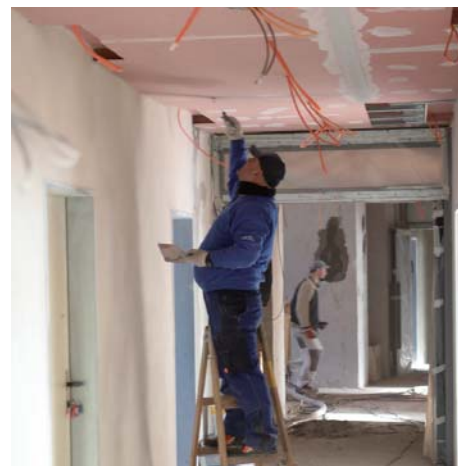
Chodba v prvním patře. Kabely jsou ukryty ve stropě pod sádkartonovými deskami, které je nyní potřeba vyspárovat a přebrousit.
