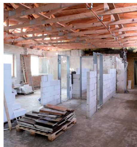
Pomalu se rýsují obrysy nové kuchyně s novým dřevěným krovem.
