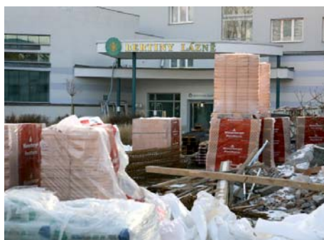
Současný jižní vchod.
